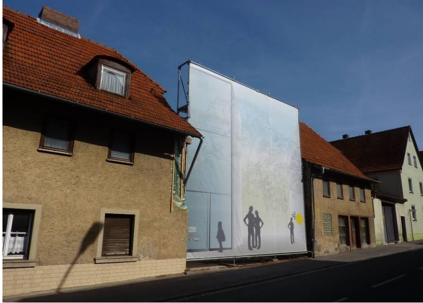
Standort des Stadtlauringer Modellprojekts Beckenstraße/Kettenstraße, nach Teilrückbau, Baulückenfüllung durch Großtransparente © FORUM
