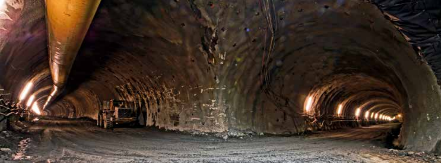
Raccordo tra la galleria di accesso di Ahrental e il cunicolo esplorativo di Innsbruck.
