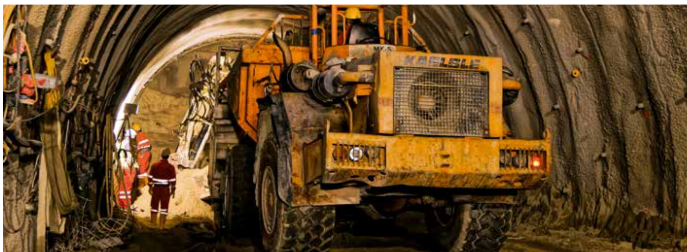
Ultimi lavori alla galleria di accesso di Ampass.
