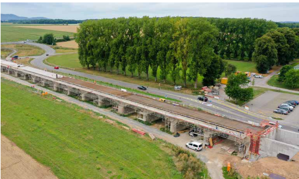
St 2275, Instandsetzung der Mainflutbrücke Haßfurt
