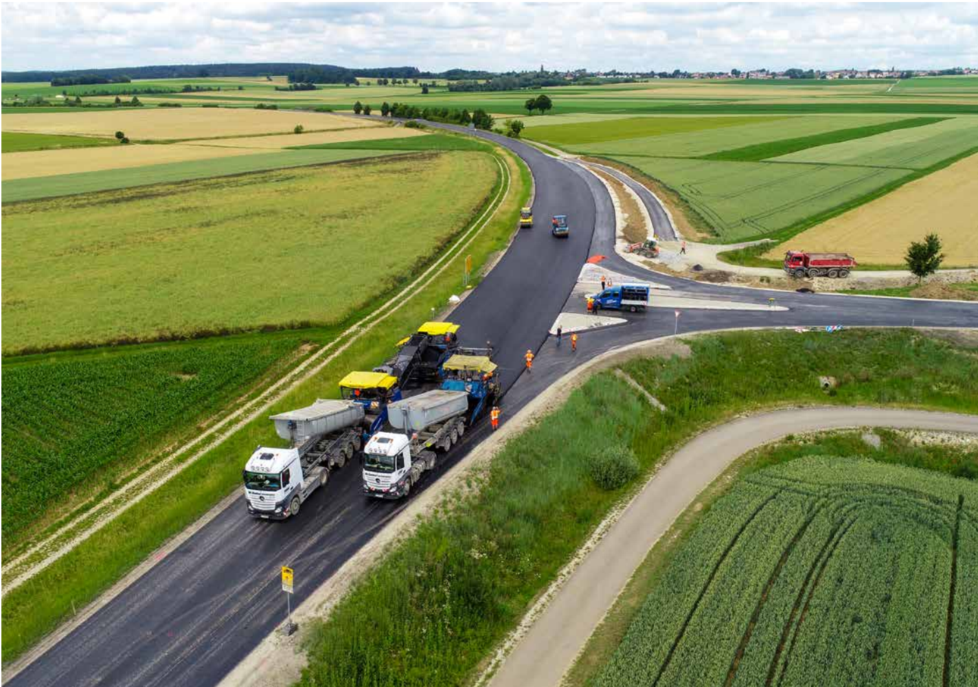
B 13, Fahrbahnerneuerung bei Eitensheim
