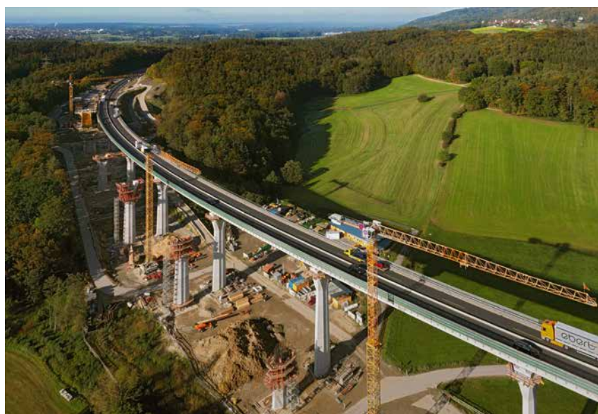
A 3, Talbrücke Unterrieden
