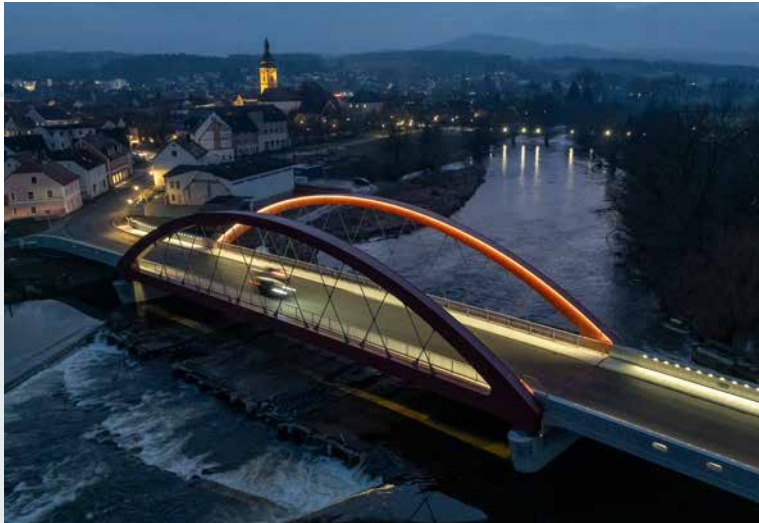
St 2145, Erneuerung der Brücke über den Regen in Nittenau
