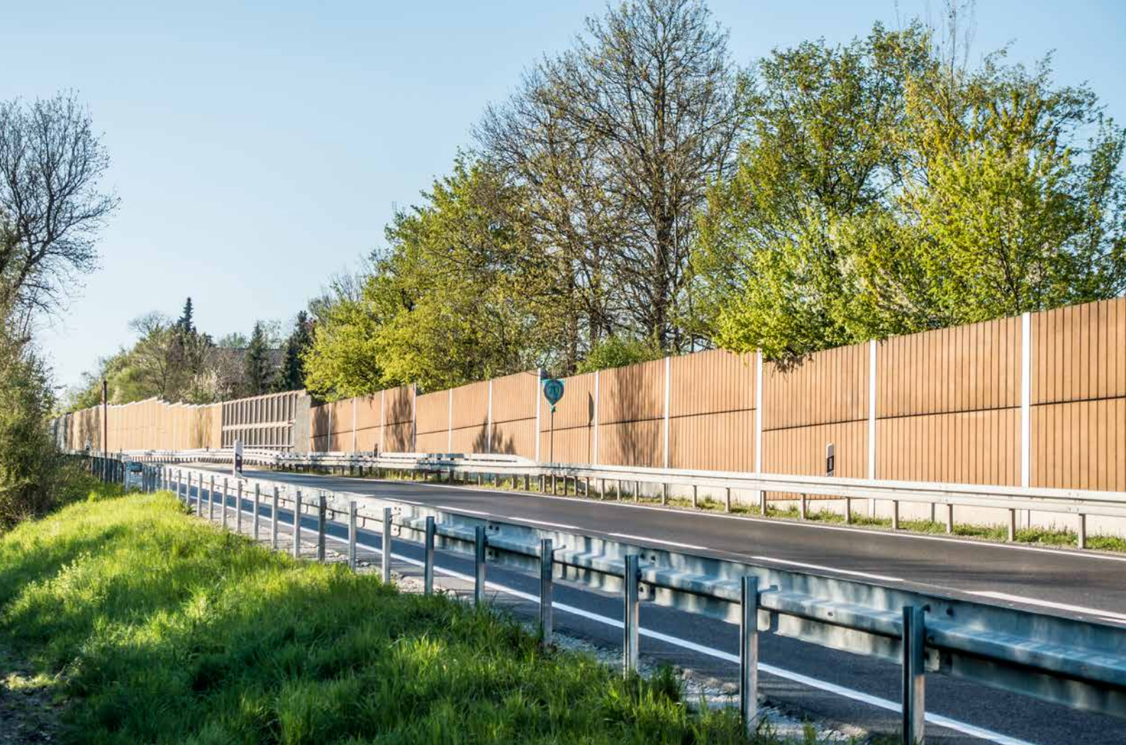
Reduzierung des Verkehrslärms durch eine Lärmschutzwand
