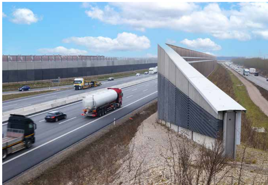
A 3, sechsstreifiger Ausbau südlich Regensburg mit Lärmschutz
