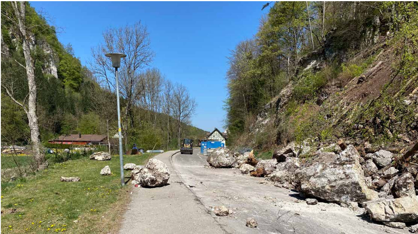
St 2392, Felsberäumung unter Vollsperrung bei Kipfenberg im Altmühltal
